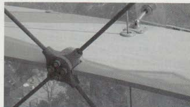
写真7 圧縮リングと金物1 Photo 7 Compression ring and stainless fittings 1
